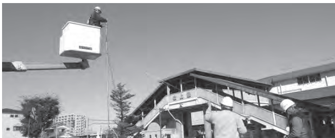
▲イルミネーション取付作業の様子
