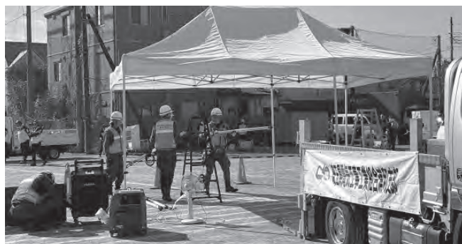
▲ライフライン（電力）の復旧訓練の様子
