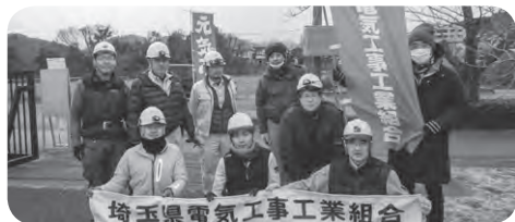
仮設電気の送電作業に参加した組合員
