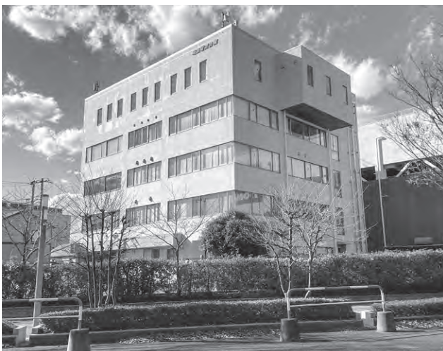
埼玉電気会館
