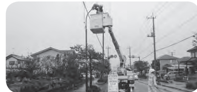
清掃作業の様子
