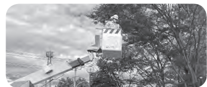
高所作業車体験搭乗の様子
