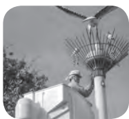
高所作業車での作業の様子
