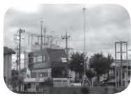
イルミネーション 取付作業の様子
