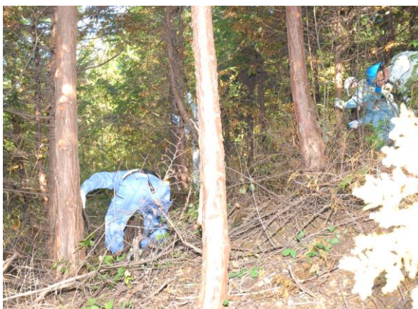
作業後の様子
