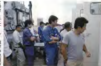
屋上に設置された設備を見学
