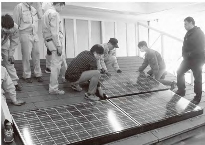
太陽光発電設備の据付実習
