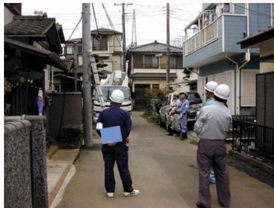
引込線安全パトロール
