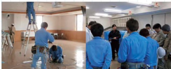
埼玉電気会館 LED 化工事
