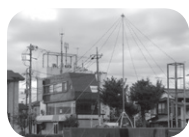
イルミネーション 取付作業の様子
