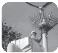
高所作業車での作業の様子
