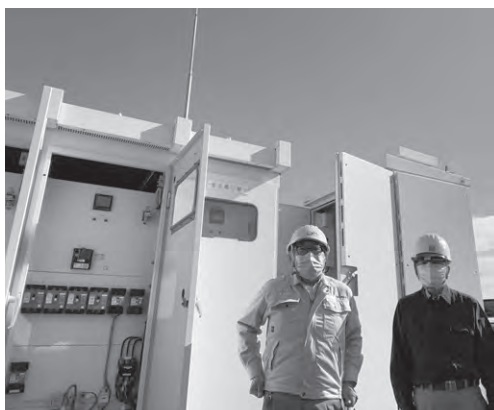
リチウムイオン蓄電設備
