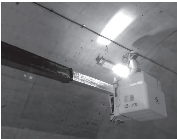
長瀬トンネル照明更新工事の様子
